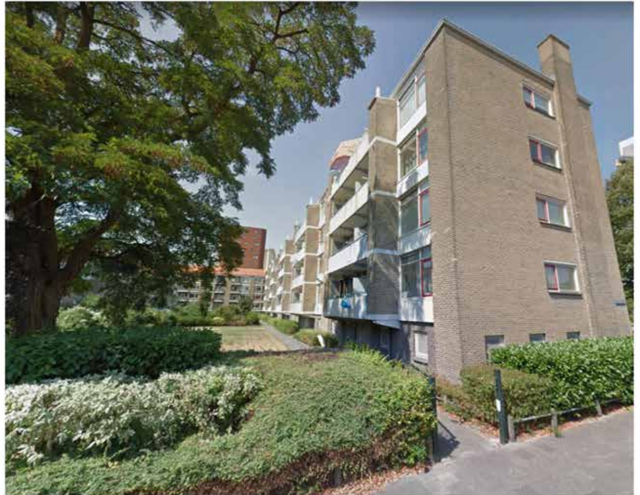
Zuidgevel woningen aan Aalbersestraat
